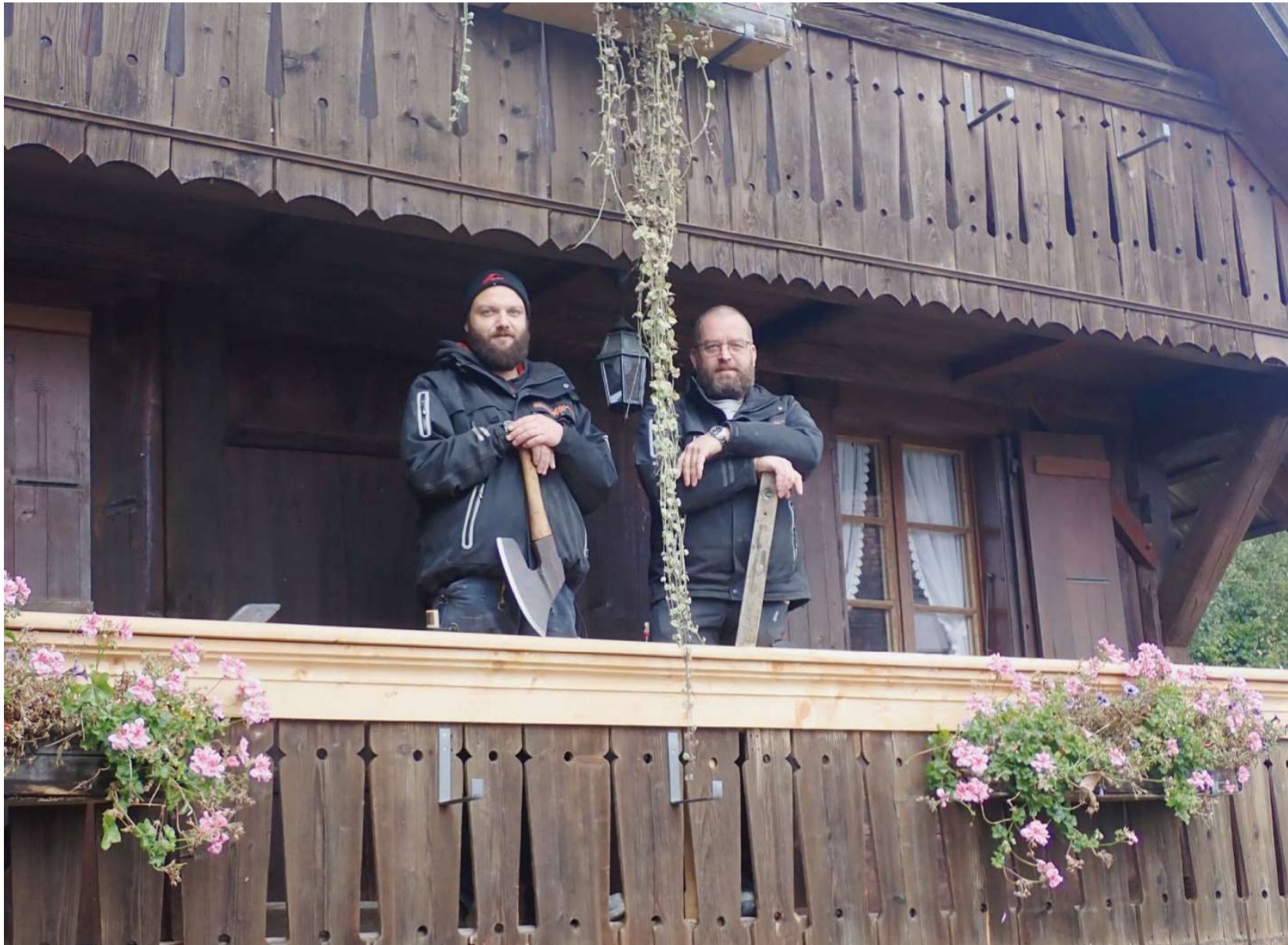
Wenn Dächer fliegen lernen: Für die Restaurierung dieses Balkons musste das halbe Haus gehoben werden. Im Bild: Max Winkler und Firmeninhaber Beni Brouwer (v.l.). ZVG
